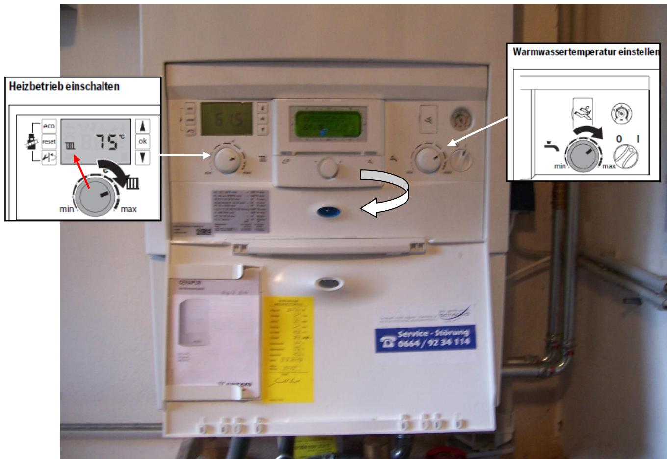
Warmwassertemperatur (50°C) einstellen: Durch Drehen am rechten Rad wird die Warmwassertemperatur im Display angezeigt (Symbol „Wasserhahn“) – sollte auf 50°C eingestellt sein – wenn nicht, entsprechend regulieren.
